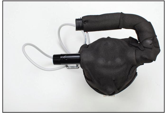
Fig. 8-53 Medidor de flujo con la flecha que indica el sentido del flujo: mismo sentido que el de la salida de la bomba de circulación
