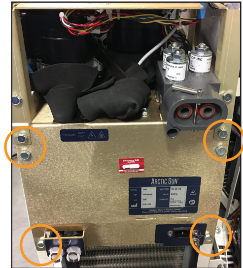
Abb. 8-36 Entfernung von sechs Schrauben (Schritt 3)
