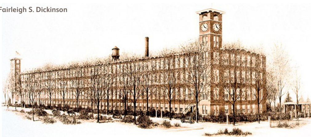
East Rutherford, New Jersey (1906), virksomhedens første fabrik og hovedkontor
